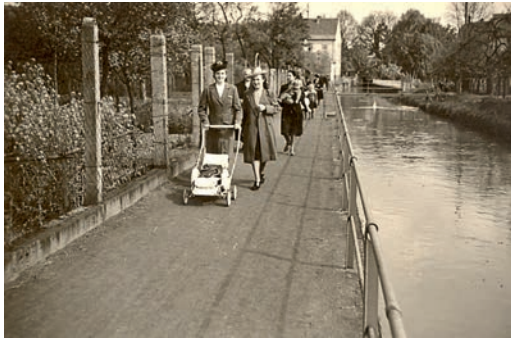
Zwischen Karlsruher Straße und Kaiserstraße früher
