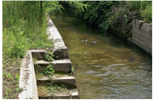
Treppe zum Mühlkanal
