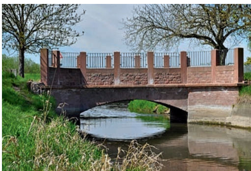
Kraichbach mit Fuß- und Radfahrerbrücke
